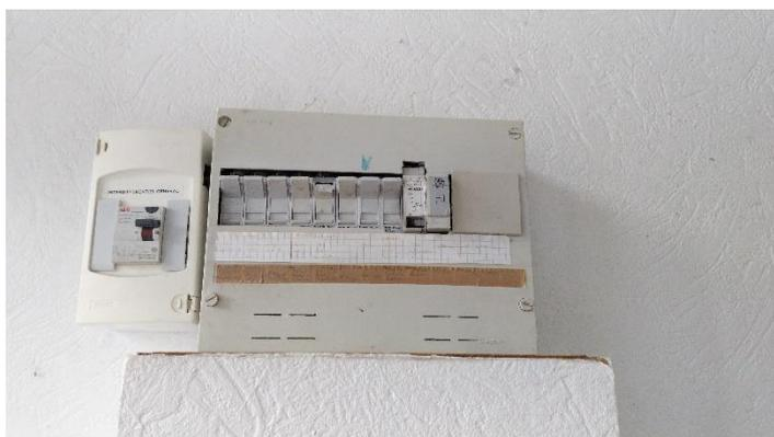
Le disjoncteur différentiel installé en amont des fusibles
